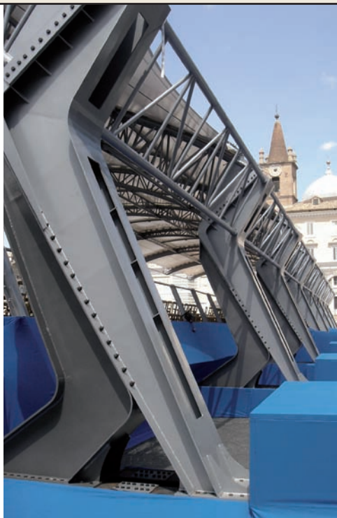
Vista posteriore: in primo piano un piedritto
