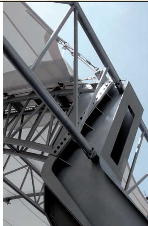
Un punto di attacco della membrana tessuto-pvc
